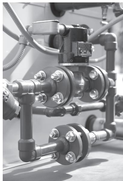
Рис. 6.12. Главным преимуществом регулирования условных проходов трубопроводов с помощью электромагнитных клапанов является возможность иметь разное давление газа и воздуха на входе, главными недостатками — сложность настройки системы и низкая надежность
